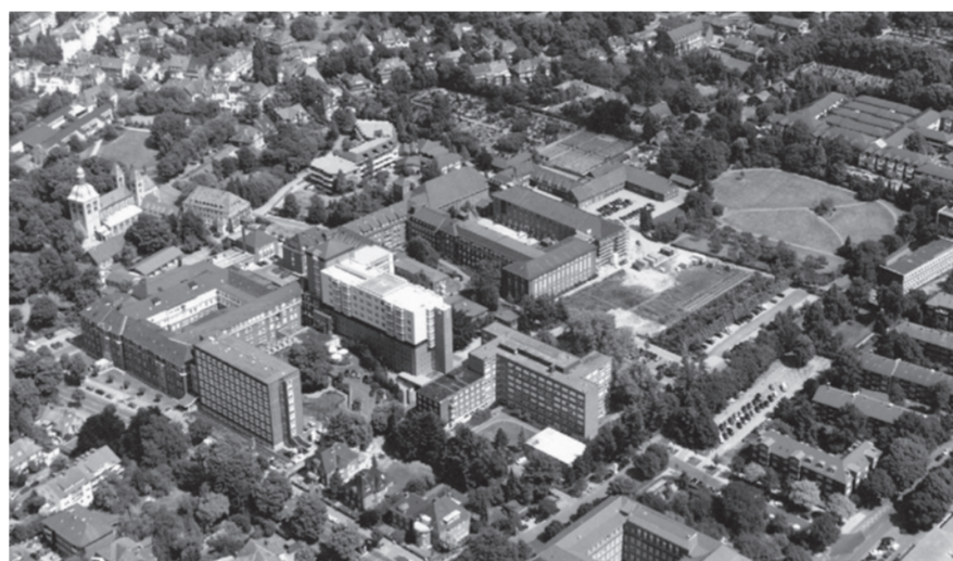
In der Mitte dieser Luftansicht des St. Franziskus-Hospitals ist der weiße Aufbau auf dem verklinderten Bunker gut zu erkennen.
